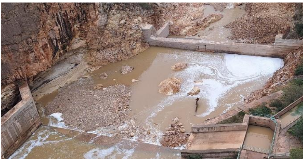
Figura 9. Cuenco amortiguador de la presa de Forata.
